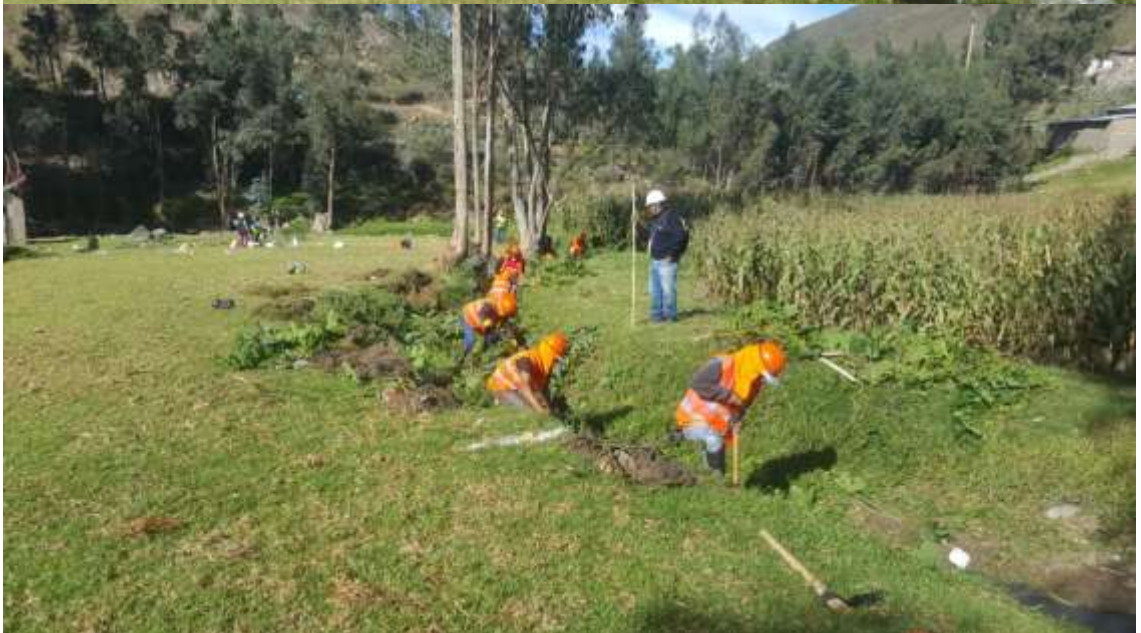
Entrega de terreno, charla de inducción de seguridad e inicio de trabajos de limpieza y descolmatación en la quebrada “La Retama”.
