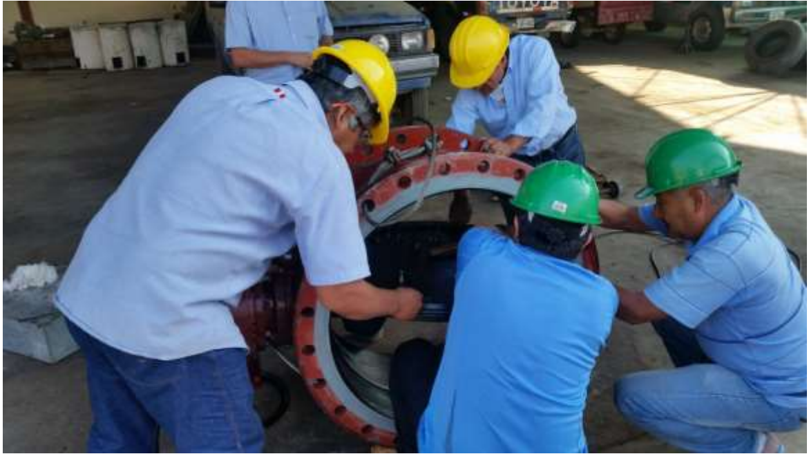
FOTO N° 03 ACONDICIONAMIENTO Y PINTADO INTERNO DE VALVULA
