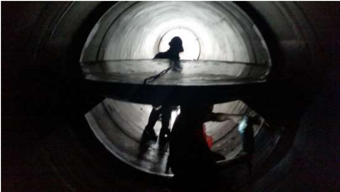
FOTO N° 08 MANTENIMIENTO DE LA LENTEJA DE LA VALVULA MARIPOSA
