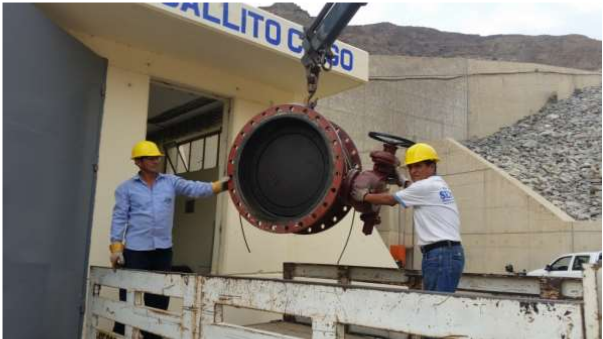
FOTO N° 04 MONTAJE DE VALVULA DE LA MINICENTRAL
