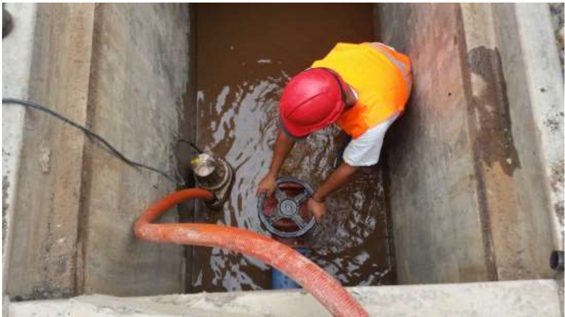
FOTO N° 09 REPOSICION DE LAS VALVULA BETA DEL CANALITO GALLITO CIEGO
