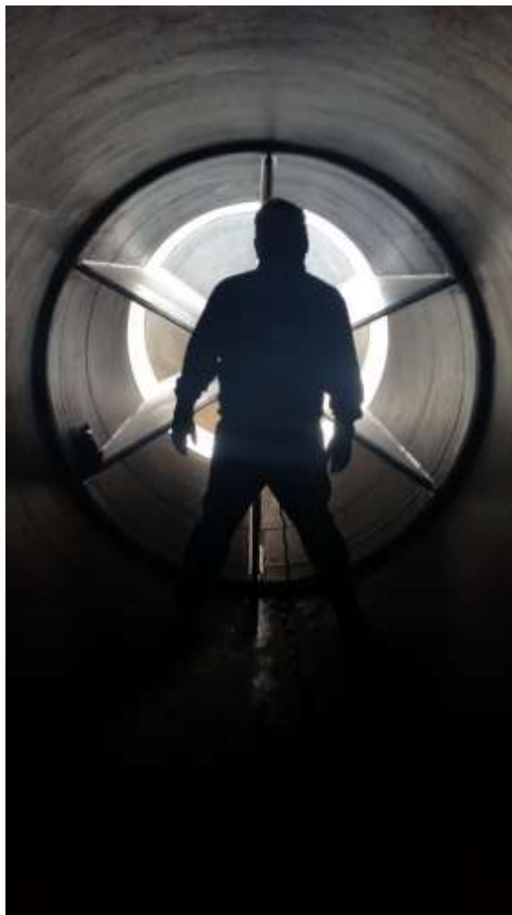
FOTO Nº 07 INSPECCION DEL CONDUCTO DE VALVULA MARIPOSA DE LA ESTRUCTURA TERMINAL
