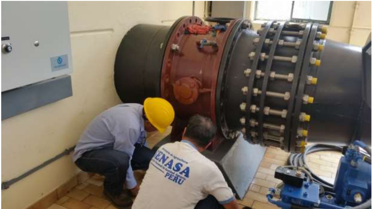
FOTO N° 01 DESMONTAJE DE LA VALVULA MARIPOSA MINICENTRAL
