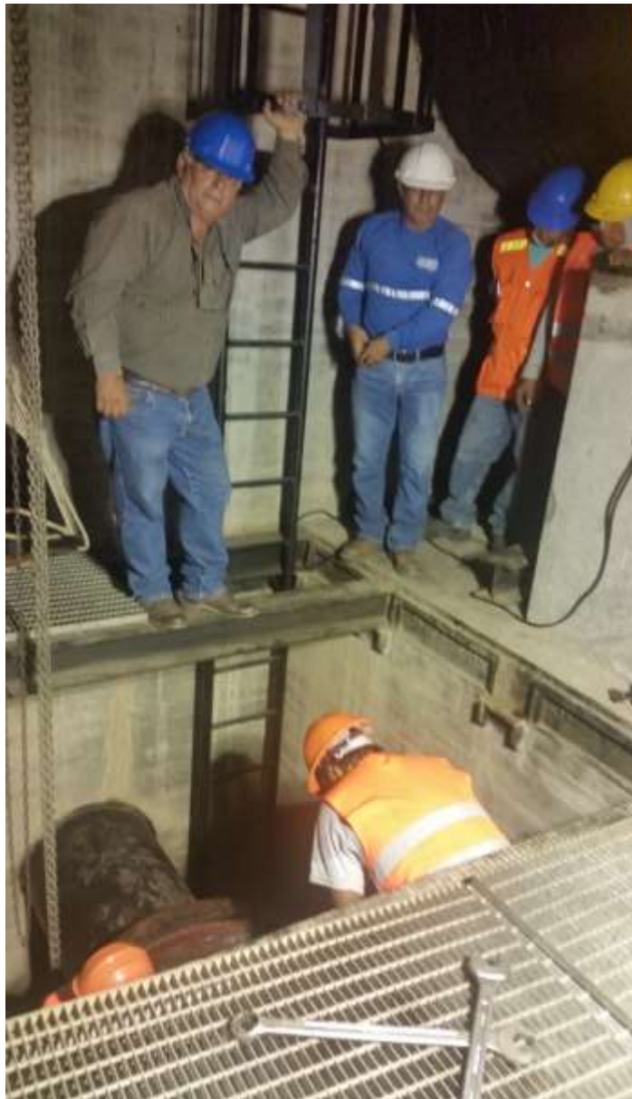
FOTO N° 05 SUPERVISION DE LA VALVULA DE DRENAJE DEL TUNEL
