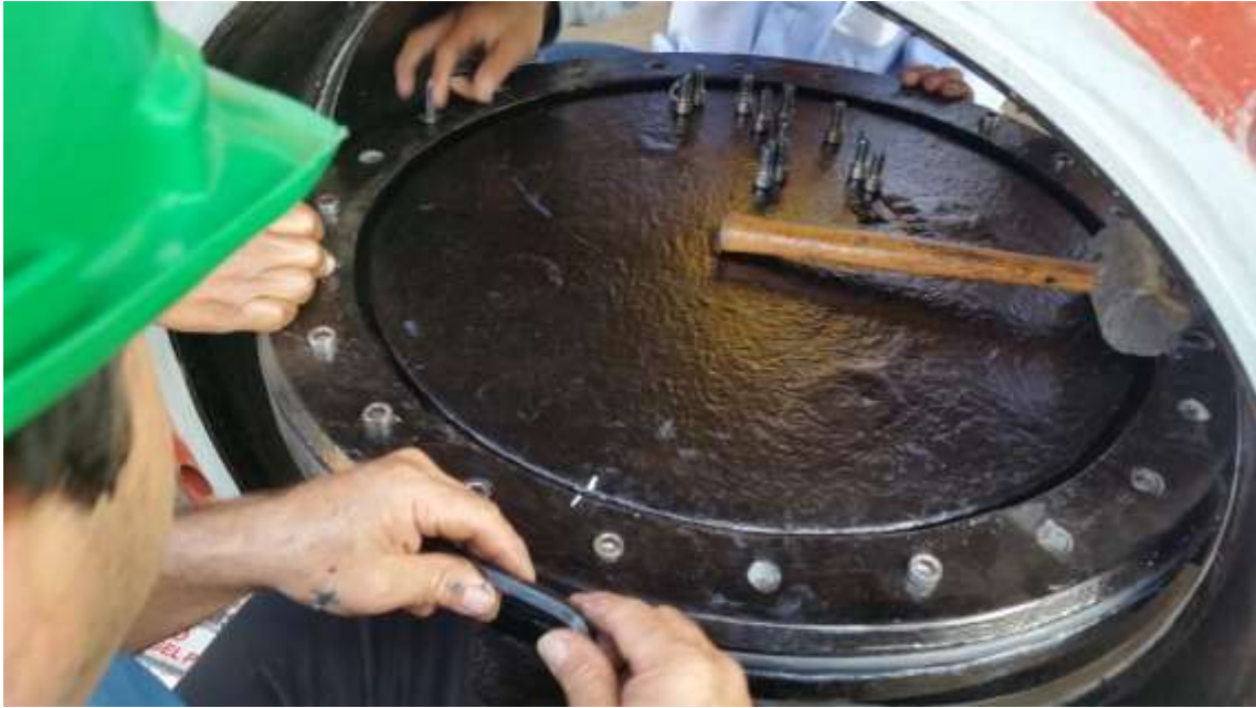
FOTO N° 02 CAMBIO DE EMPAQUETADURAS DE JEBE DE LA LENTEJA DE LA VALVULA
